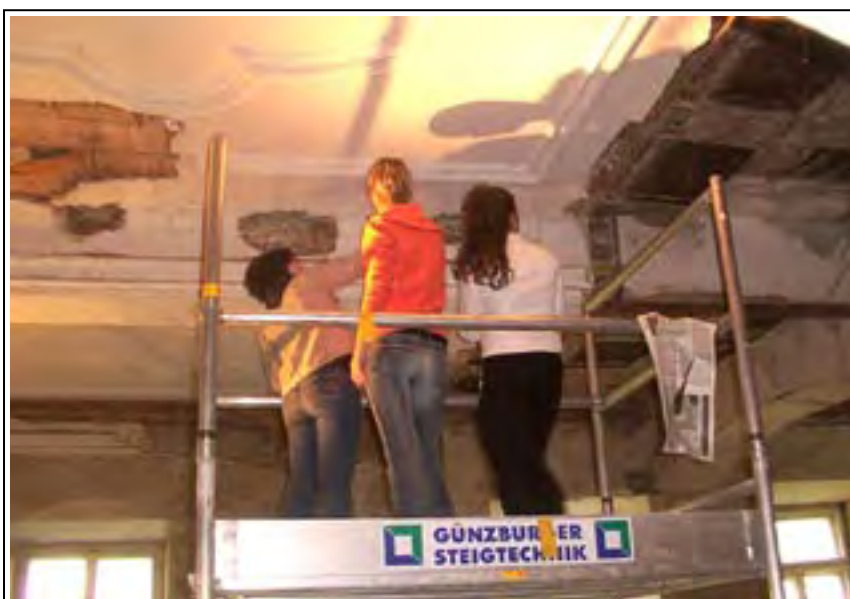
Denkmal aktiv - Dokumentation einer Stuckdecke
